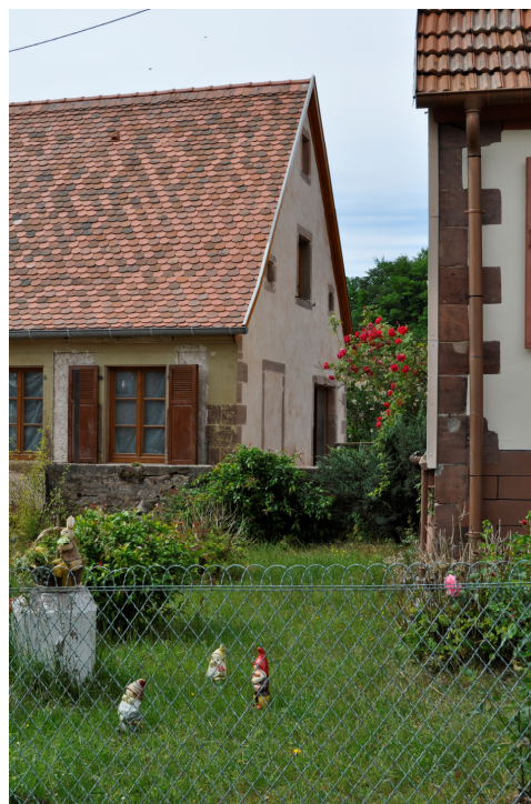
Eco-rénovation à Wingen sur Moder
